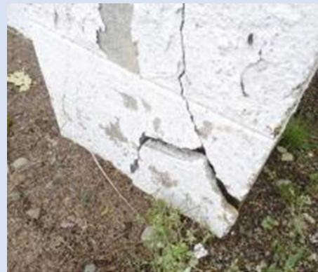
基礎モルタル亀裂・剥離
