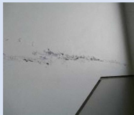
共用階段部の亀裂・塗装剥離
