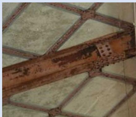
結露による鉄骨錆び
