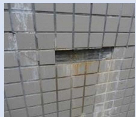
外装タイル部分亀裂・剥離
