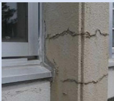
外壁(柱)亀裂
