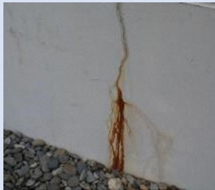
基礎モルタル亀裂(内部配筋サビ)
